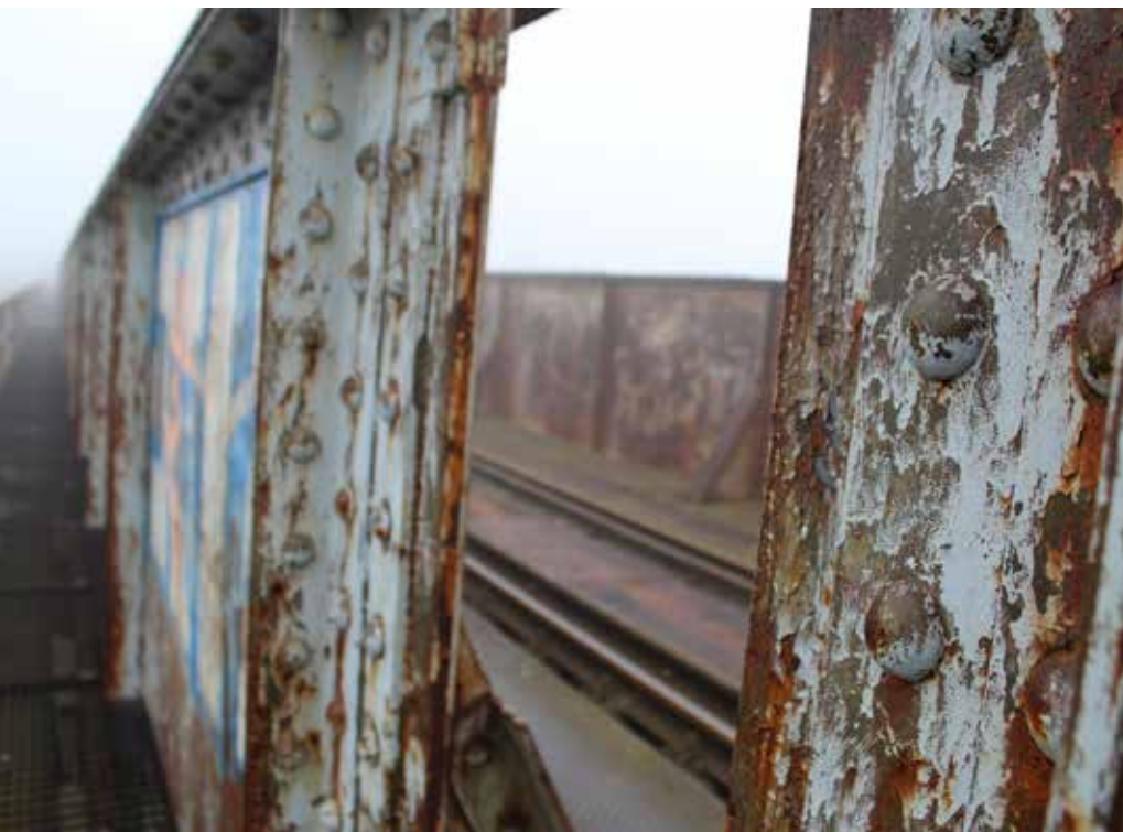
LK 367 - most kolejowy nad kanatem ulgi w Gorzowie
