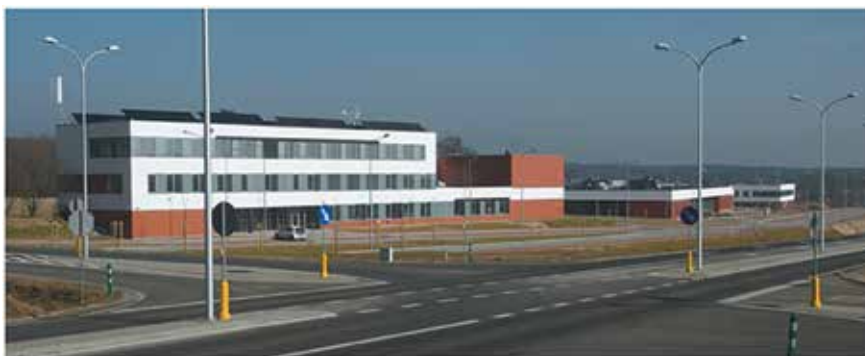
Fot. 1. Centrum Budownictwa Zrównoważonego i Energii w Parku Naukowo-Technologicznym Uniwersytetu Zielonogórskiego w Nowym Kisielinie k/Zielonej Góry
