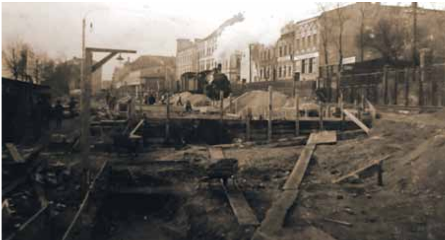
Tak powstawała gorzowska estakada kolejowa na trasie Berlin-Królewiec
