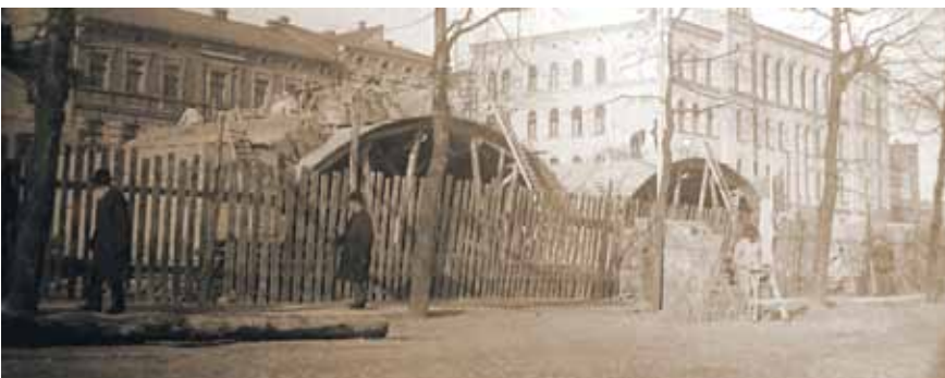
Budowane tuki estakady wzdłuż dzisiejszego Bulwaru Wschodniego
