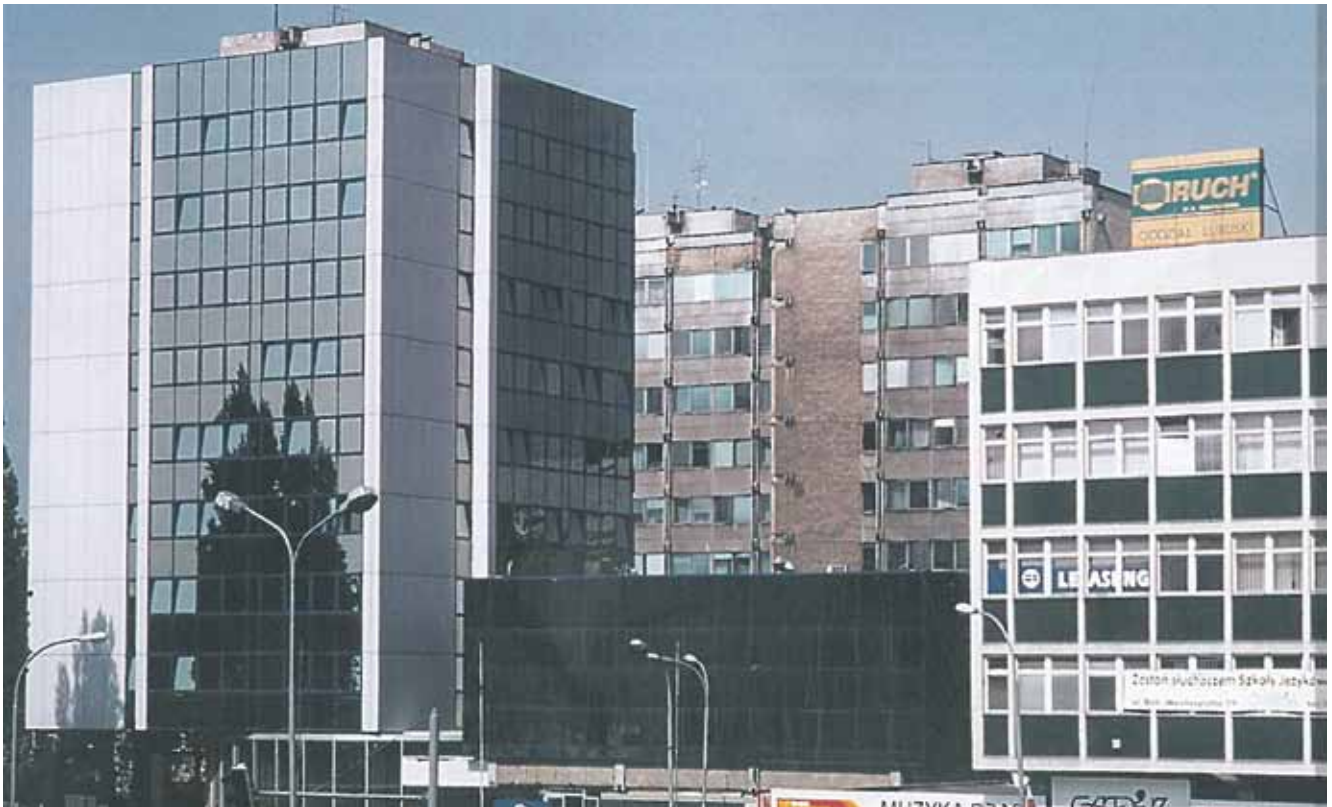
Centrum administracyjno-usługowe przy ul. Westerplatte w Zielonej Górze zrealizowane przez ZPB w latach 1967-1981
