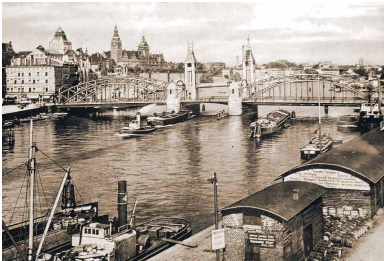
Nieistniejący Most Kłodny w Szczecinie, jedna z wielu budowli z udziałem Beuchelta na Pomorzu
