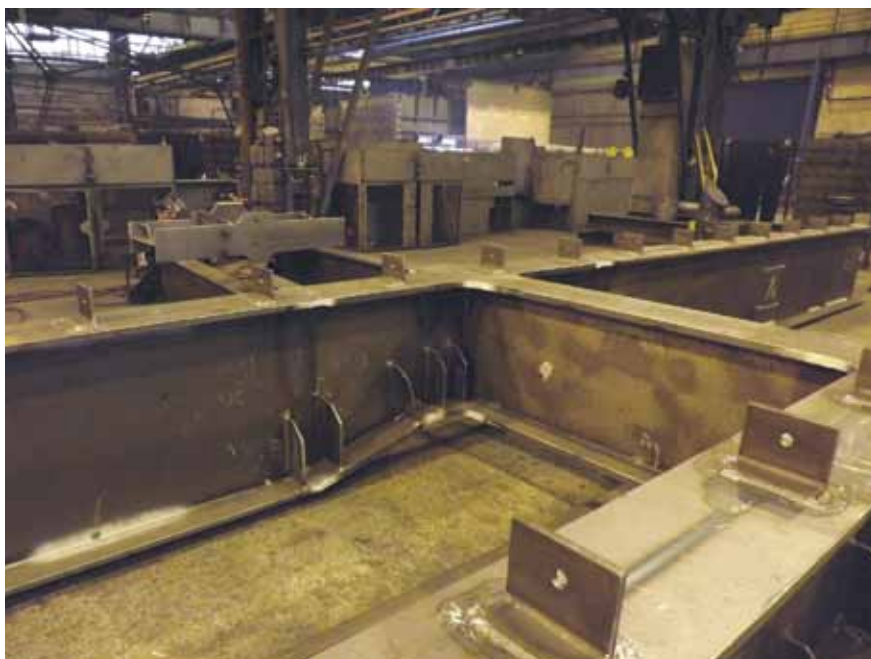
Wyjazd techniczny do zakładu produkcyjnego konstrukcji stalowych – Mostostal Słupca
