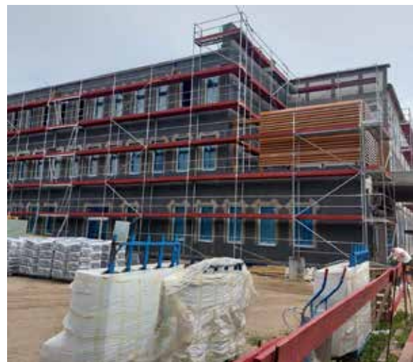
Prace związane z rozbudową Szpitala Na Wyspie w Żarach postępują zgodnie z założonym harmonogramem.
