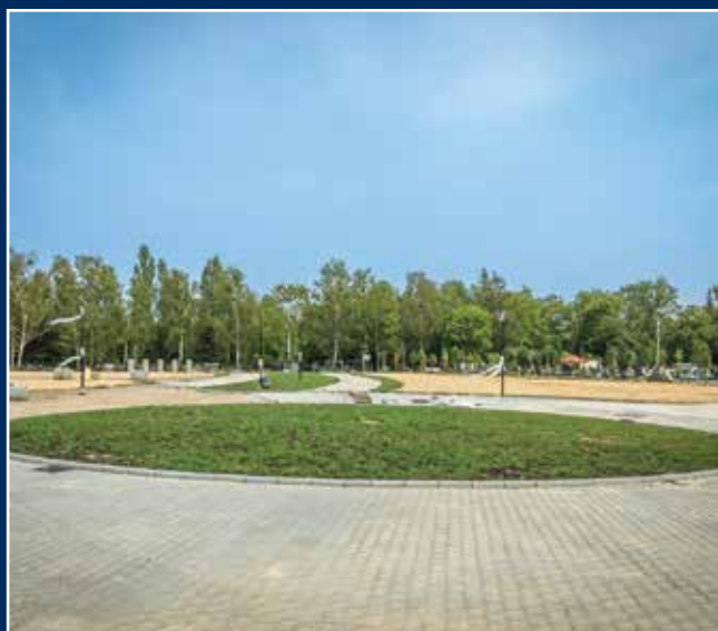
Rozbudowa cmentarza komunalnego – etap II
