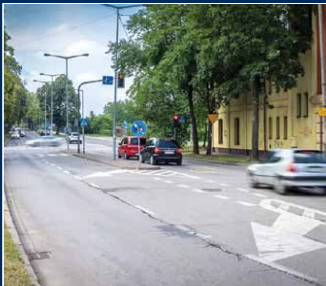
Przebudowa drogi i układu komunikacyjnego Kosynierów Gdynskich
