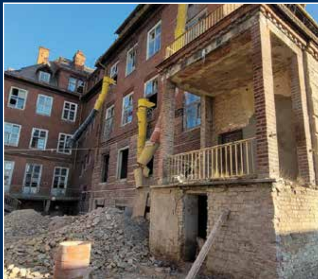
Przebudowa internatu przy Warszawskiej
