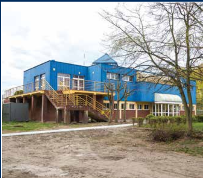
Budowa zaplecza stadionu przy Krasińskiego
