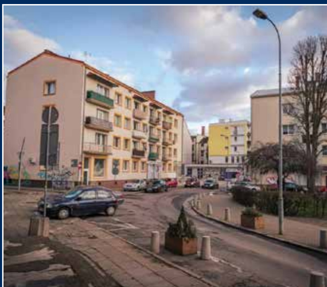
Modernizacja deptaku przy Hawelańskiej
