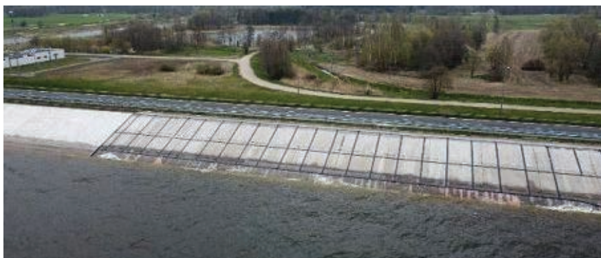
Widok z drona na montaż taśm dylatacyjnych
