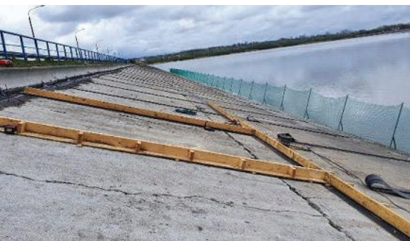
Widok na montaż szalunku
