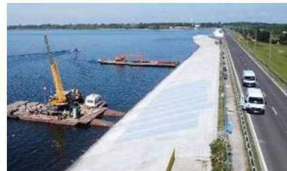
Widok z drona na prowadzone prace przy wykonywaniu umocnień podwodnych
