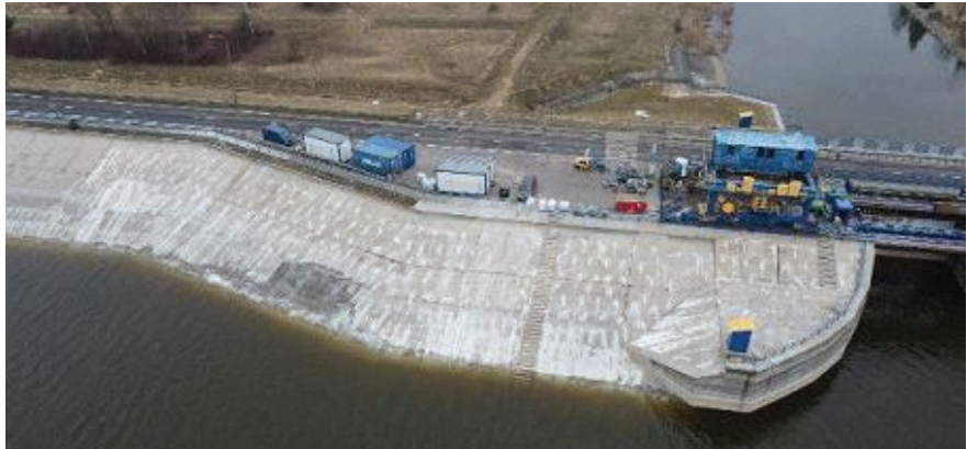
Widok z drona na wykonaną iniekcję na lewym przyczółku Jazu
