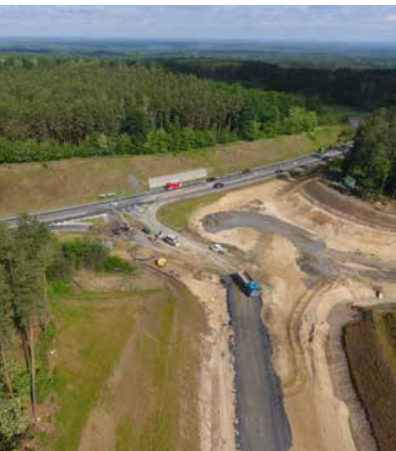
Odcinek Trasy realizowany w rejonie Wilkanowa
