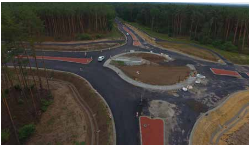
Rondo Jedności w budowie
