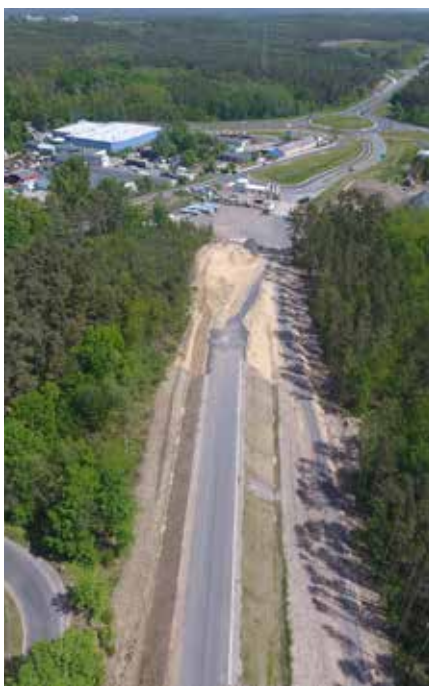
Budowa Trasy w rejonie Raculi
