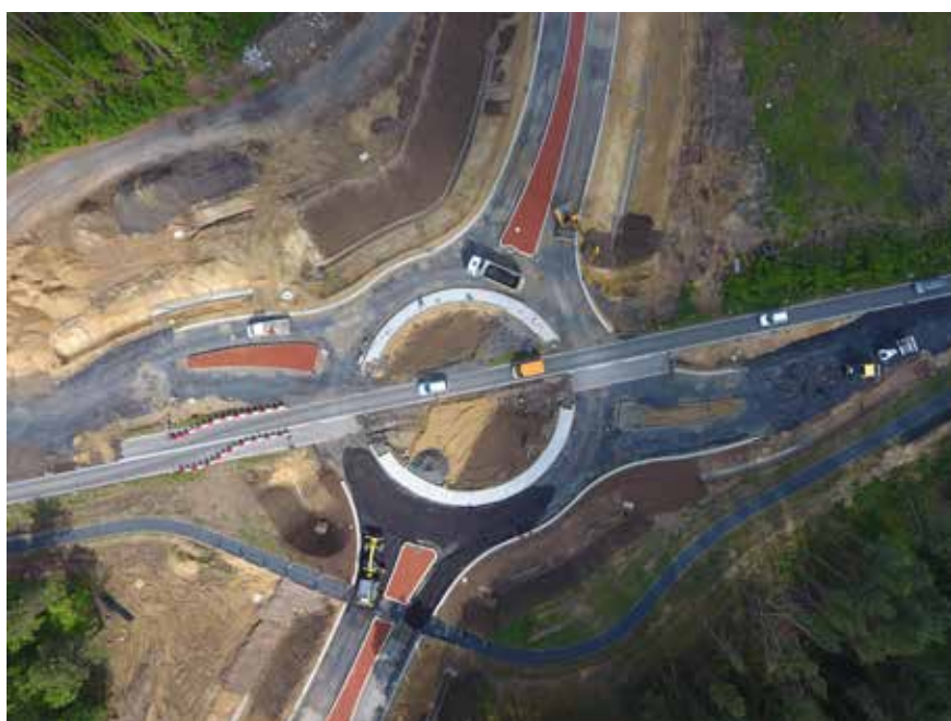
Budowa ronda w rejonie Ochli
