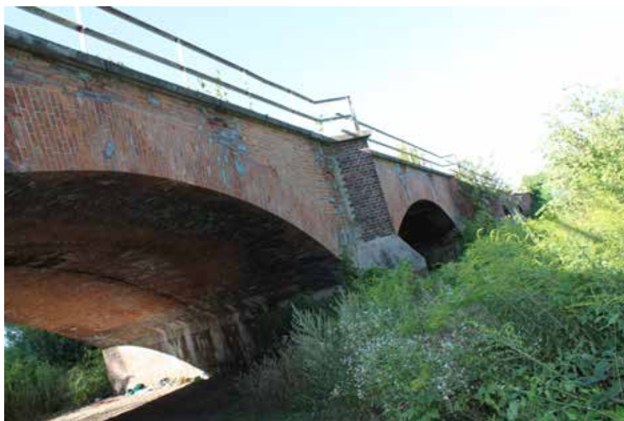
Fragment mostu kolejowego w km 341,872 linii kolejowej nr 203 nad tzw. Suchodołem w Kostrzynie (fot. Adam Oziewicz)
