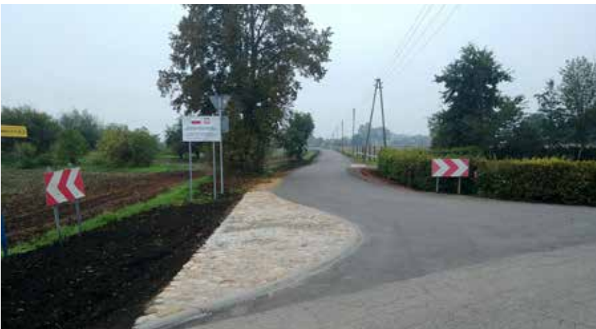
Przebudowana droga gminna Chwałowice – Roszkowice (fot. materiały UG Bogdaniec)
