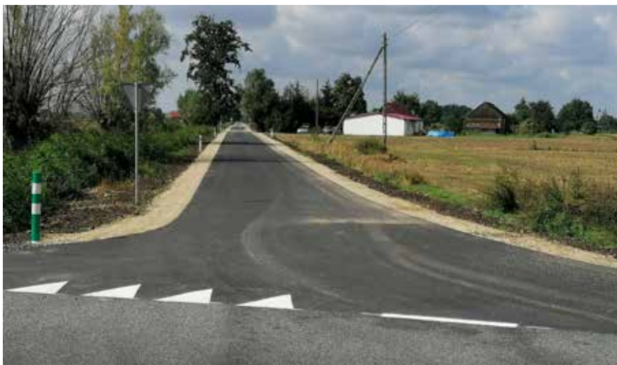
Przebudowana droga gminna w Lubczynie (fot. materiały UG Bogdaniec)
