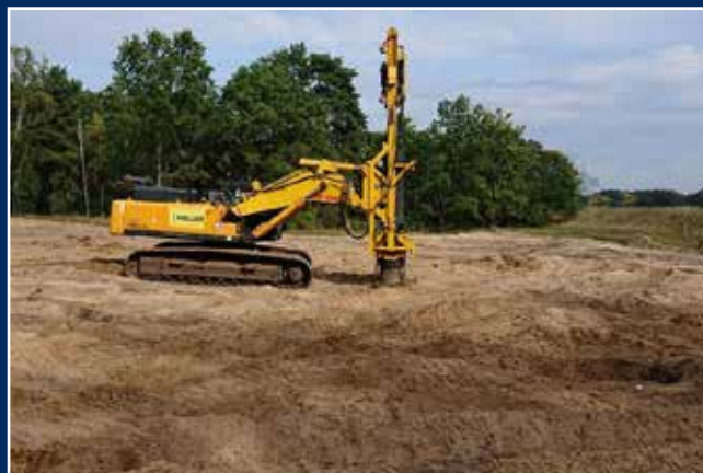
Technologia impulsowego zagęszczania gruntu (IC)
