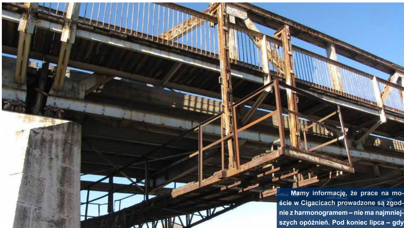
Widok na wózek rewizyjny od strony Zielonej Góry – zdemontowany
