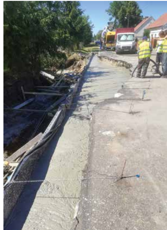
Naprawa drogi powiatowej Kórnik
