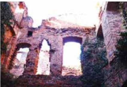
Ubytki w ścianie wewnętrznej. STAN: LISTOPAD 2015
