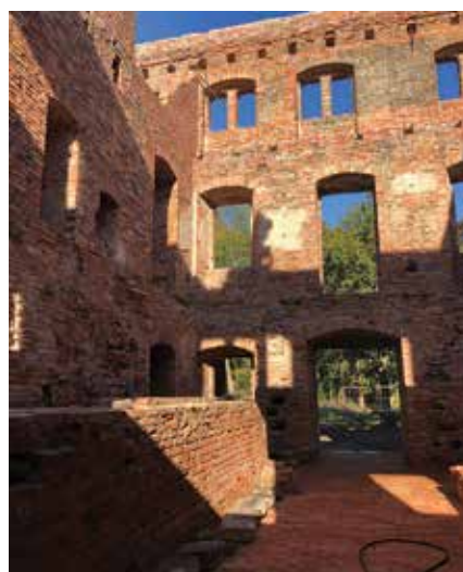
Widok obiektu po zakończeniu prac budowlanych – październik 2018
