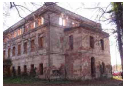
Ściana szczytowa od strony parku. STAN: LISTOPAD 2015
