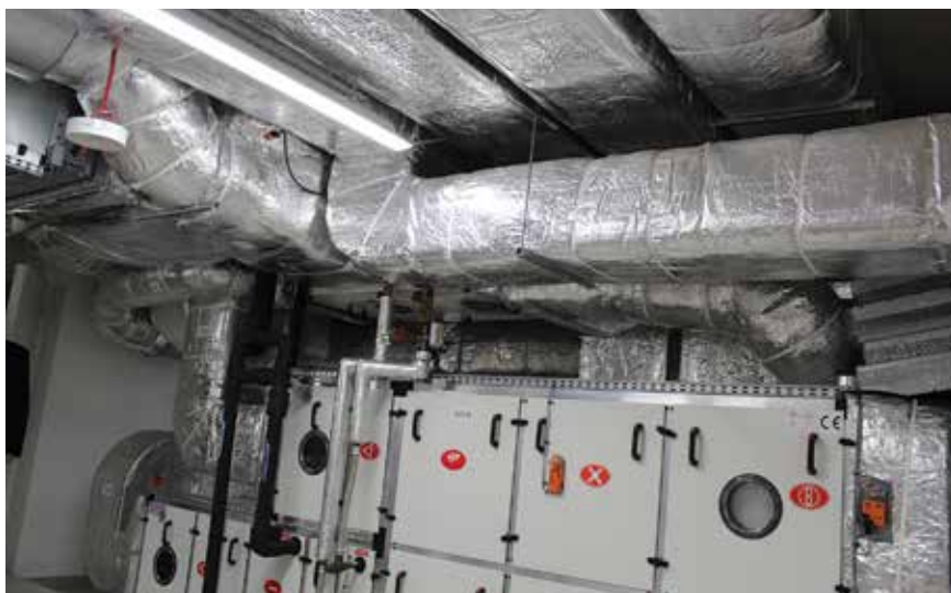
Część techniczna obiektu – podziemia
