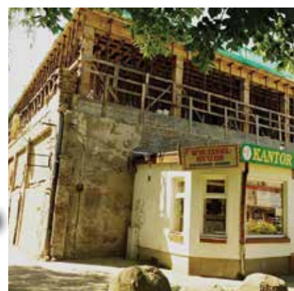
fot. 6 – realizacja konstrukcji stropu nad piętrem
