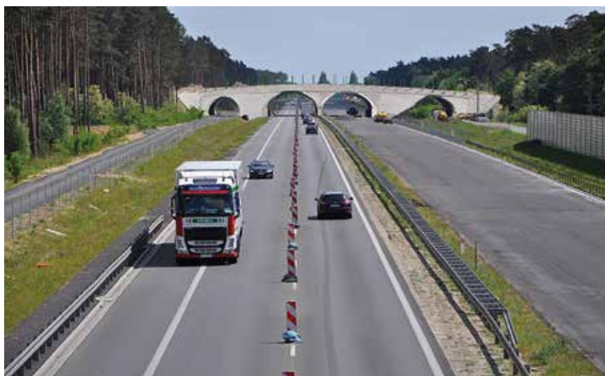
Lubuski odcinek drogi ekspresowej S3 ( www.gddkia.gov.pl )
