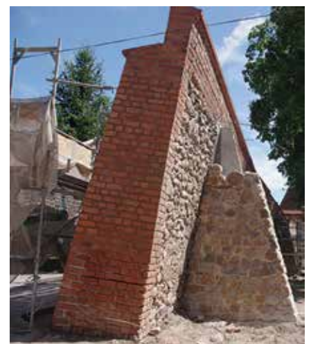
fot. 3. Widok muru z gotową przyporą żelbetową licowaną murem z kamienia
