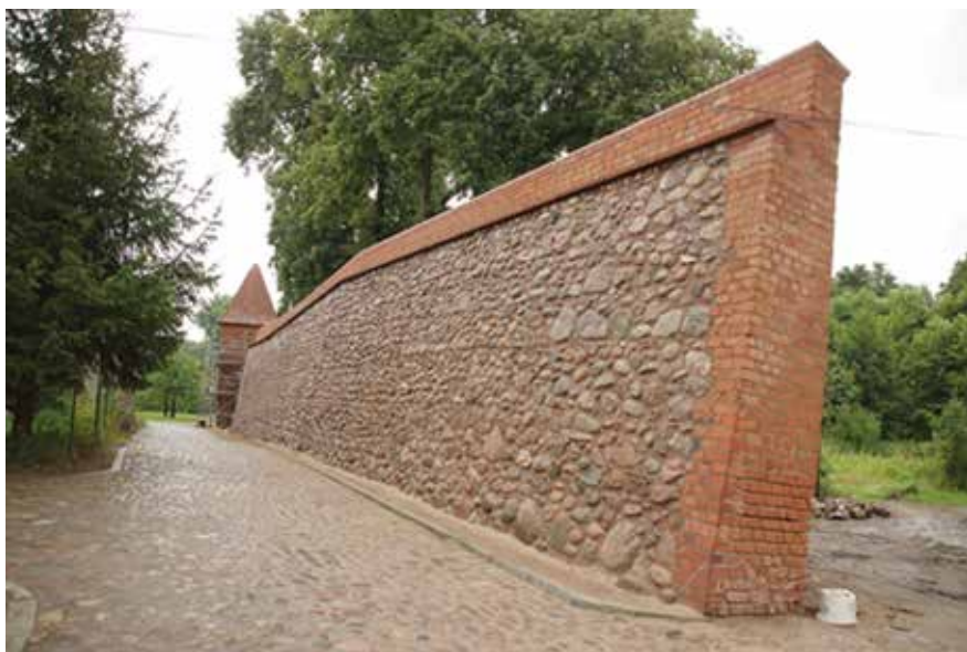
Południowo-zachodni odcinek murów obronnych, w stanie zagrożającym przewróceniem został doraźnie zabezpieczony, następnie wzmocniony i odrestaurowany.
