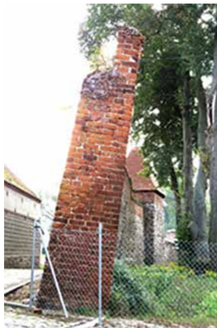
fol. 1. Mur przed zabezpieczeniem
