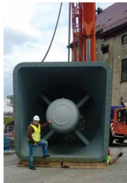
Tuż przed zainstalowaniem turbiny w EW Kopin
