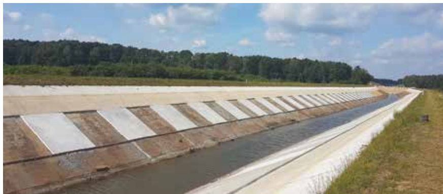
Kanał derywacyjny EW Dychów w trakcie prowadzenia prac
