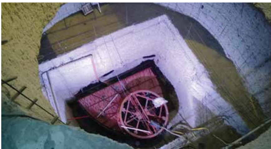
Posadowienie rury ssącej w EW Otmuchów
