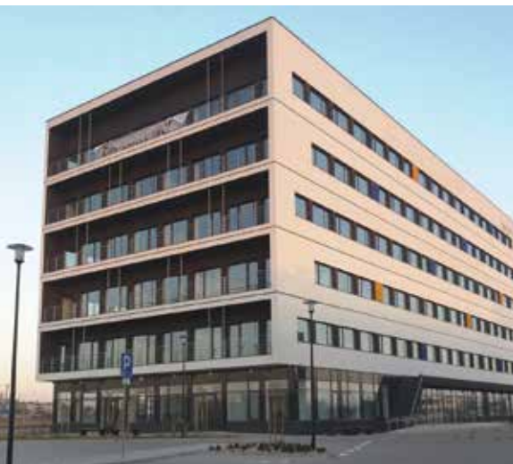
Obiekt Dolnośląskiego Parku Innowacji i Nauki we Wrocławiu
