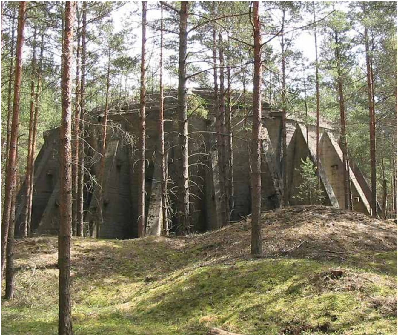
Magazyn otoczony wałem ziemnym. Pozostałości fabryki DAG Alfred Nobel w Krzystkowicach (źródło: Wikipedia/autor: Mohylek)
