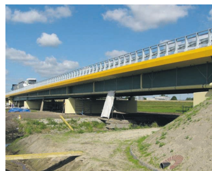
Widok mostu na obwodnicy Babimostu podczas próbnego obciążenia
