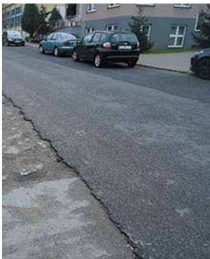
a) widok od ul. wazów,
