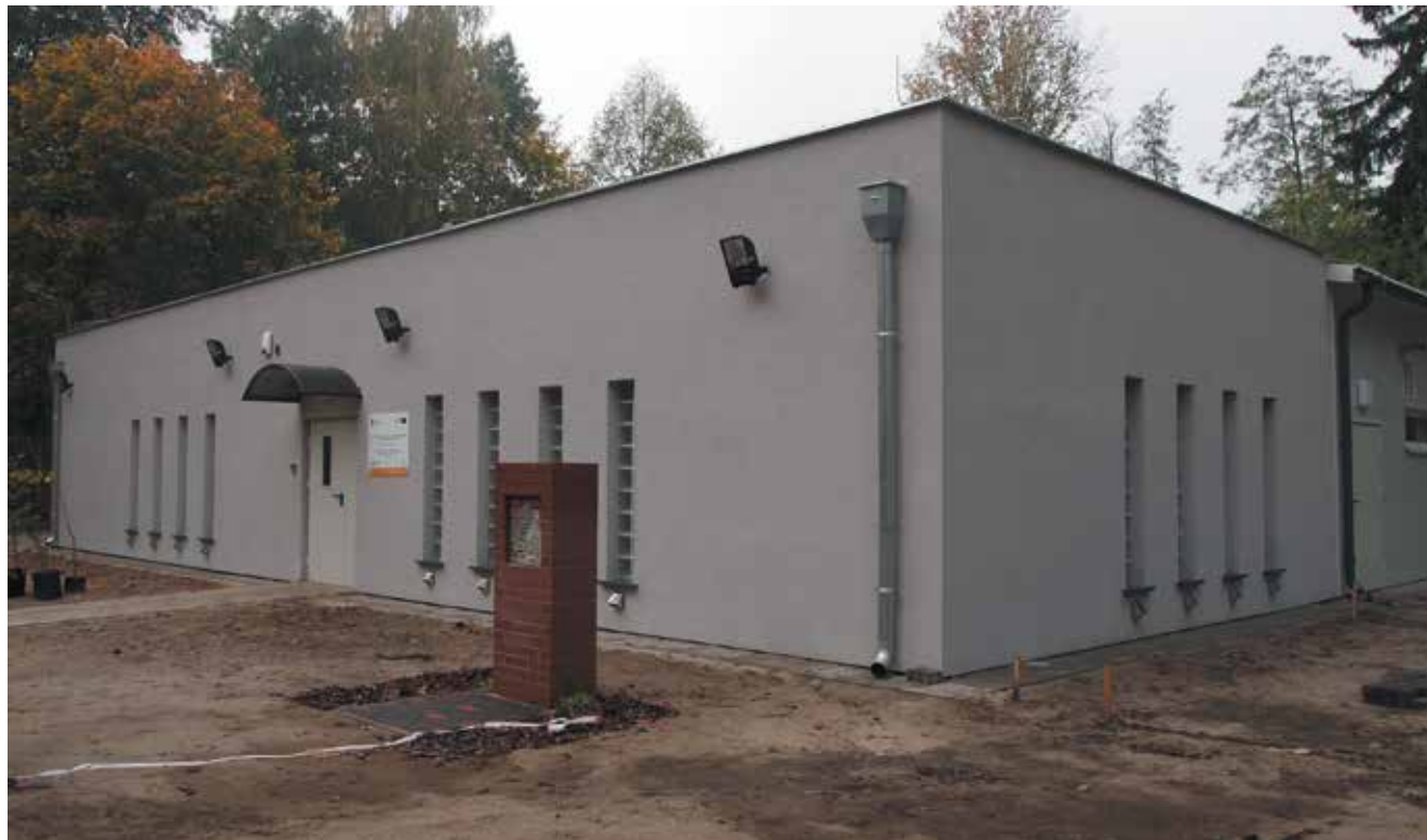
Nowa hala warsztatów (budynek hali warsztatów z zewnątrz)
