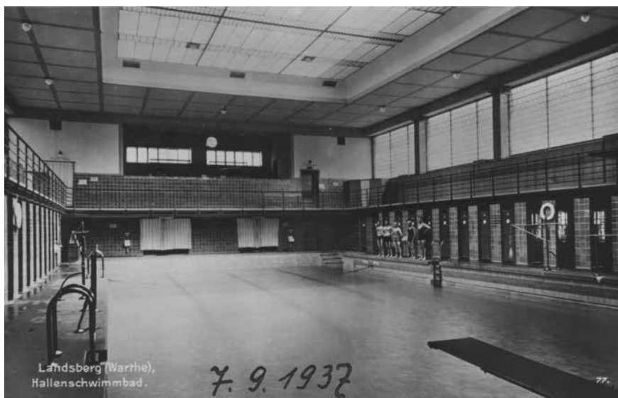
Wnętrze hali z basenem w swoim pierwotnym wyglądzie z lat 30. XX w.
