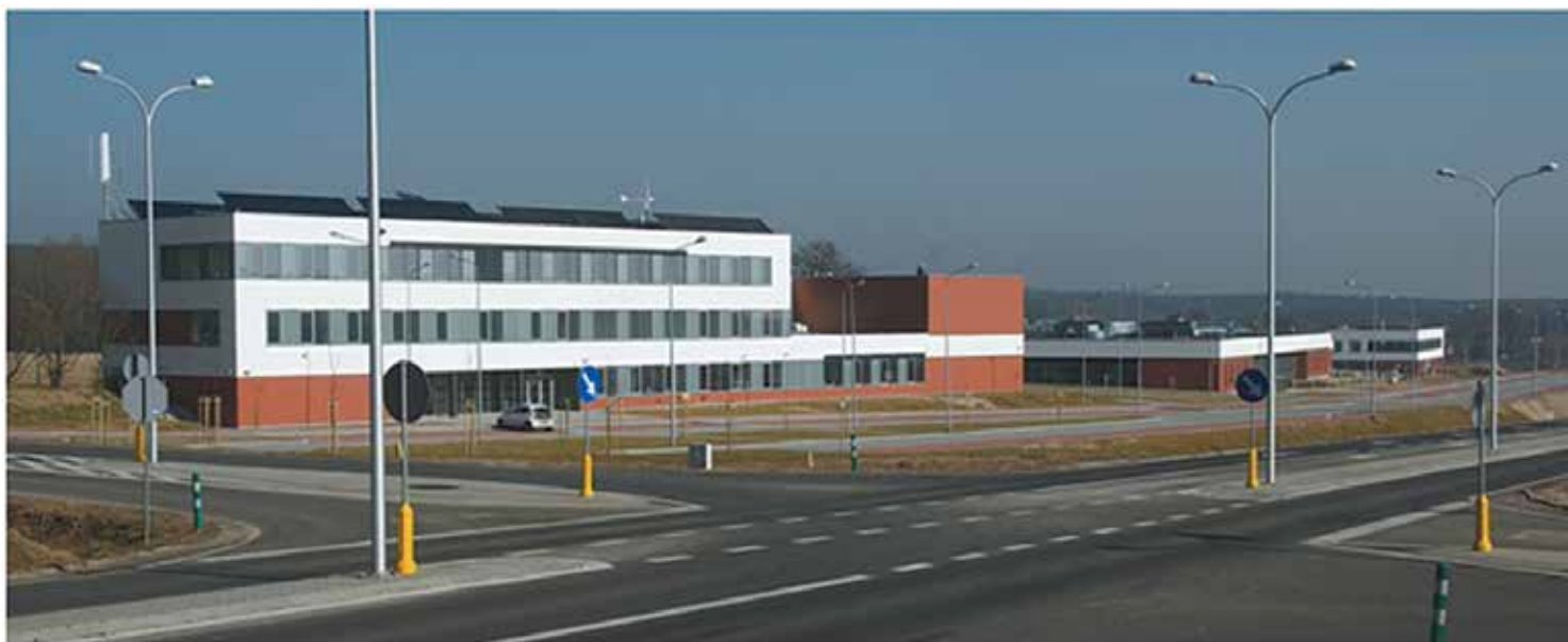
Centrum Budownictwa Zrównoważonego i Energii w Parku Naukowo-Technologicznym Uniwersytetu Zielonogórskiego w Nowym Kisielinie k/Zielonej Góry
